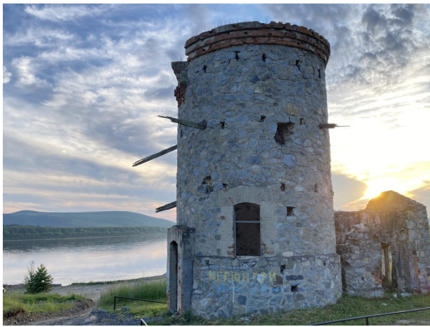
Водонапорная башня в Джалинде
